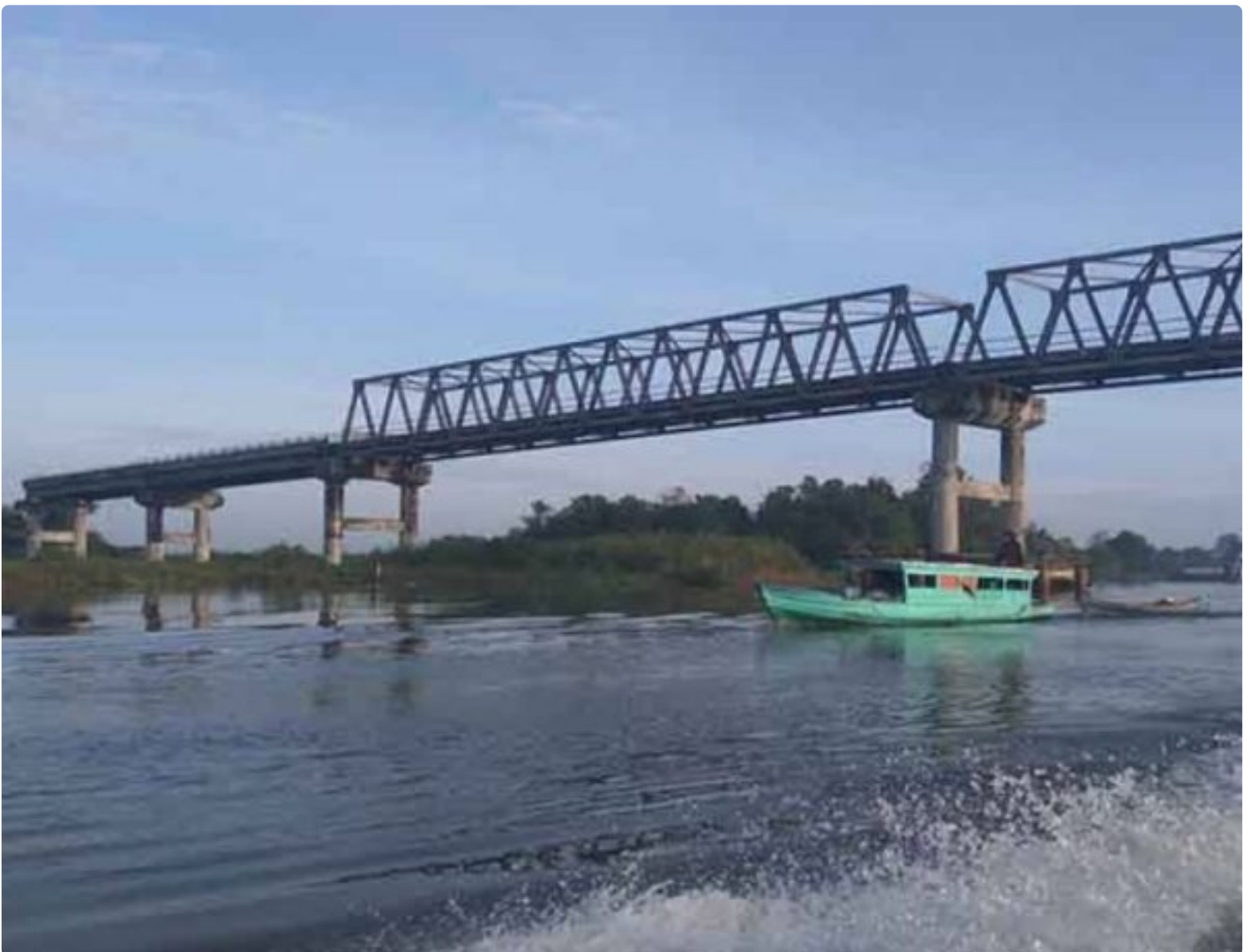
Jembatan Jelai di Kabupaten Sukamara
